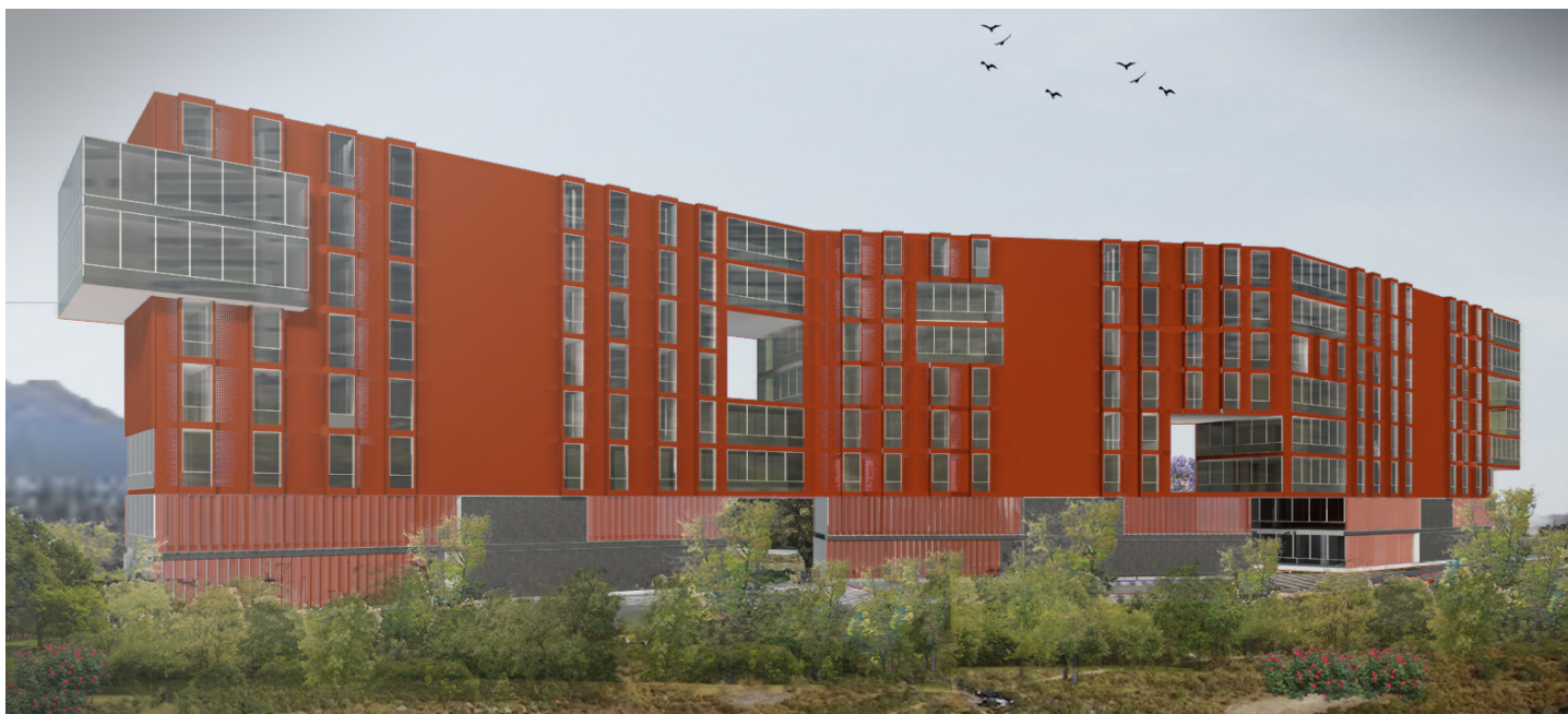
VISTA FRONTAL DEL EDIFICIO
